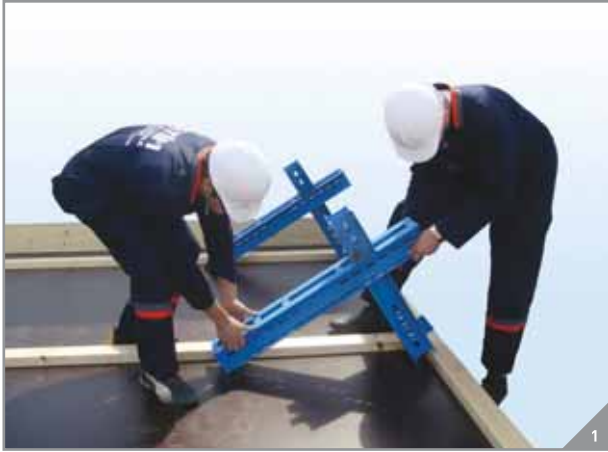
◆ Platform üzerine Köşe Bağlantı Kuşakları yerleştirilir.
