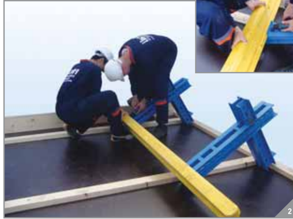
◆ Kuşaklar üzerindeki lamalara kenar ahşap kirişler monte edilir.
