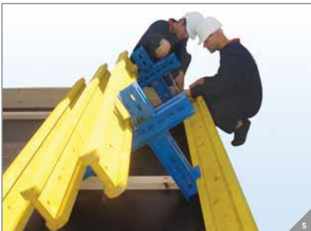
◆ Aynı işleme diğer kenarda da devam edilir. Plywood montajıyla sistem tamamlanır.
